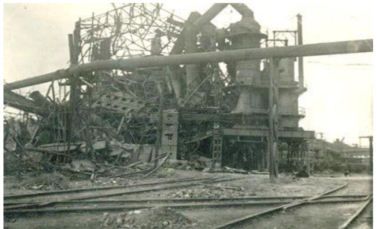
Разрушенная домна завода имени Ильича
