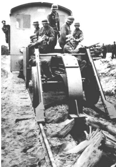
Уничтожение немцами ж.д. путей при отступлении, 1943 г.
